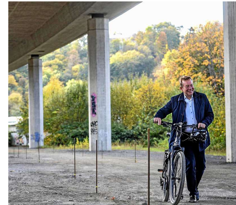
Bürgermeister Steffen Mues beim Baustart für den Radweg unter der HTS auf der Schemscheid: Warum ist da eigentlich diese Lücke?
